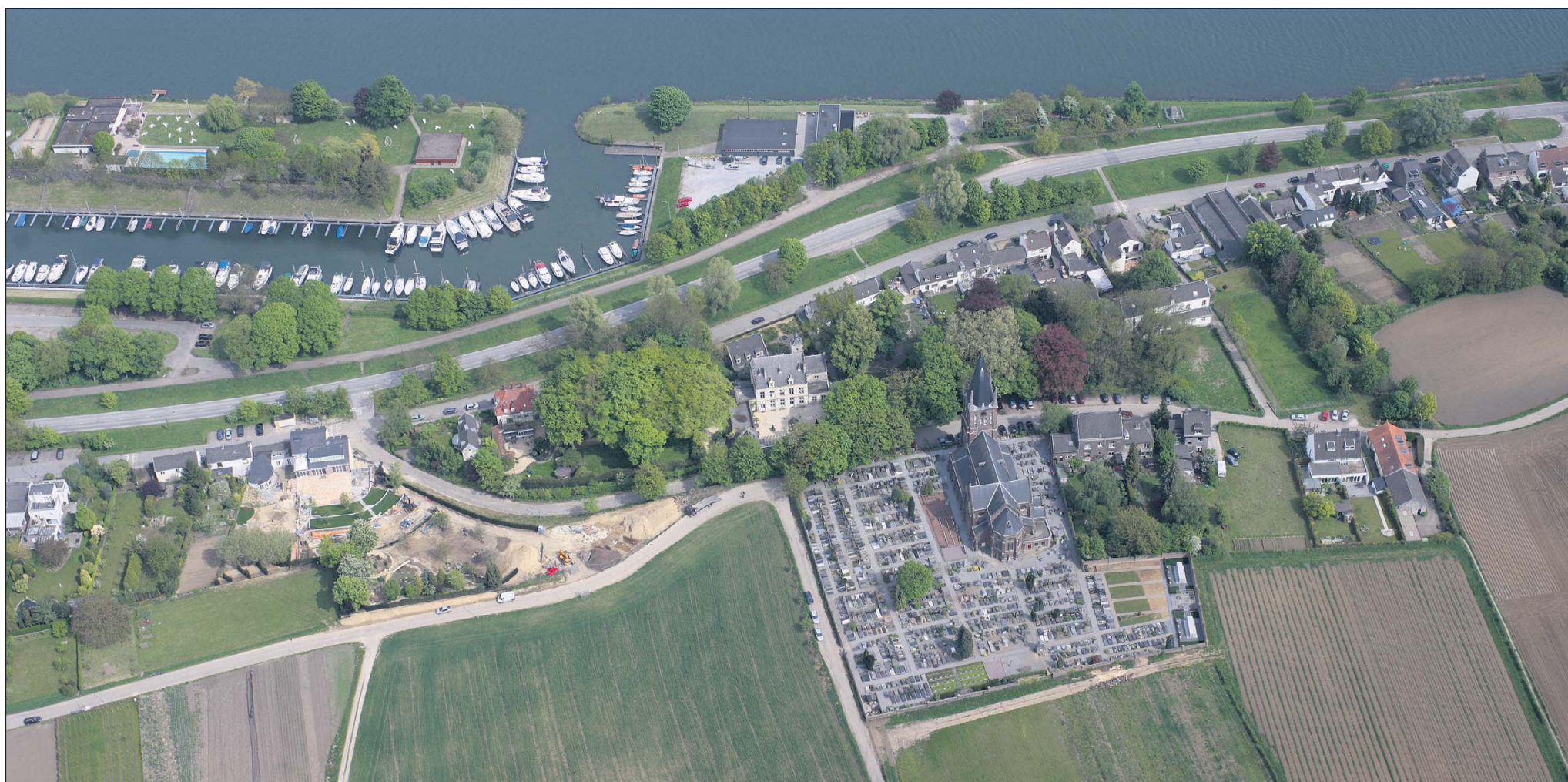
Luchtopname uit 2010. Links op de voorgrond zijn de werkzaamheden bij Pierre Rieu duidelijk te zien.
